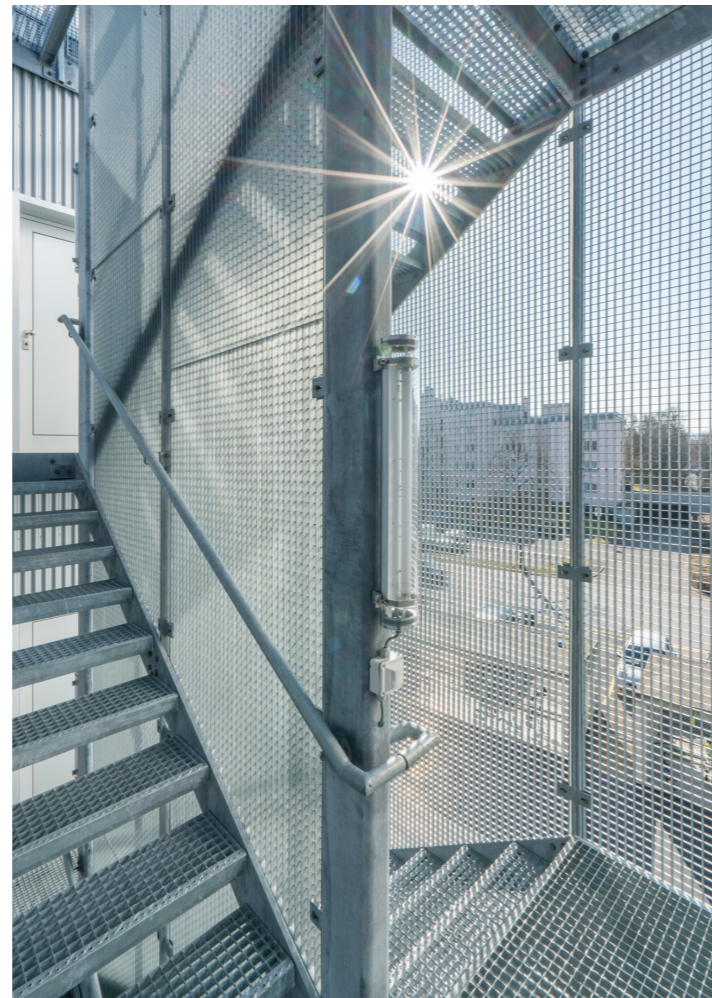
Der Treppenraum wird durch die Maschen angenehm mit Licht durchflutet.
