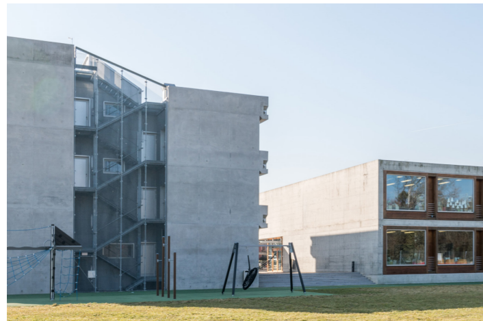
Die bestehende Stahlterasse ist mit Gitterrosten der Sprich - mit Flachrandeinfassung - eingekleidet.
